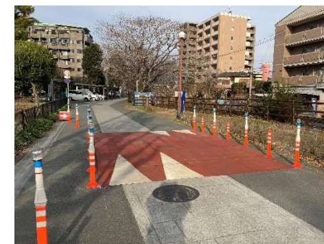
中央区新屋敷 ハンプ仮設置状況
