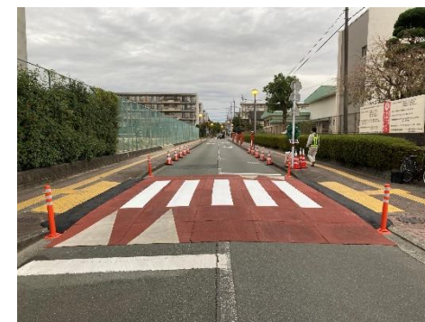
東区東町 スムーズ横断歩道仮設置状況
