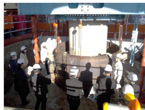
国道266号八王寺跨線橋橋梁下部の耐震補強工事を見学。補強鋼板を橋梁の基礎へ圧入する**PCウェルリフレ工法**について話を聞きました。
