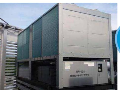
本館の冷温水空冷チラーも、設備投資により更新された機械。省エネルギーに一役買っている。
