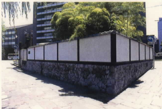
周辺の住宅地に違和感のないようデザインされた新島嶼ポンプ場
