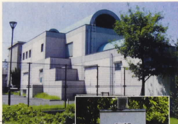
熊本城に合わせて長堀をデザインしてつくった花畑第1ポンプ場
