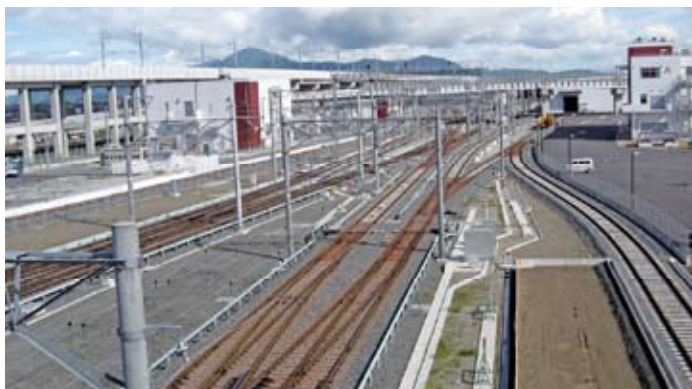
田尻跨線橋から検車庫に続く線路
