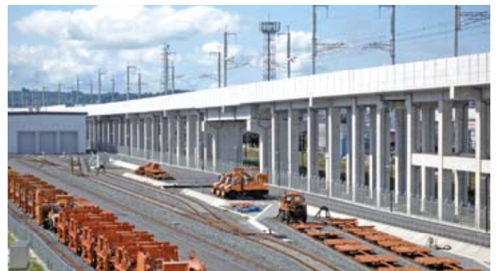
田尻跨線橋から新幹線高架橋を
