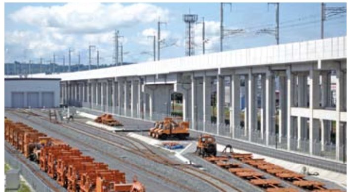
田尻跨線橋から新幹線高架橋を
