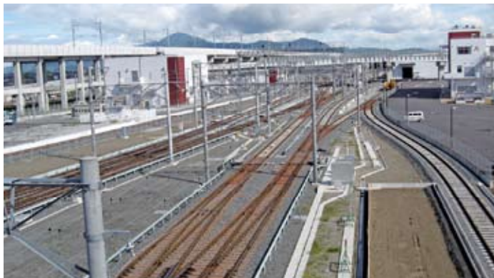
田尻跨線橋から検車庫に続く線路
