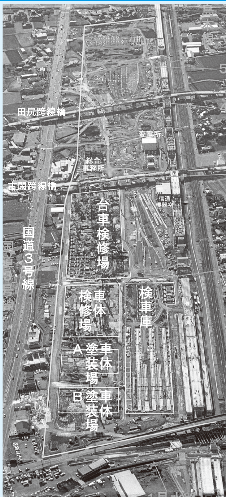
空から見た工事現場。支援機構より提供（12月26日撮影）
