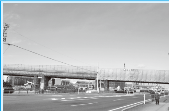
〔田尻跨線橋〕 平成21年4月開通予定
