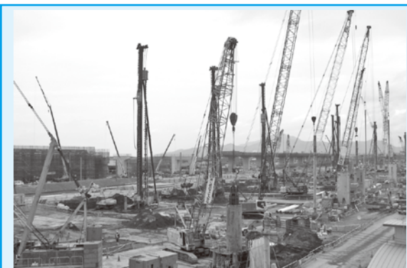
林立するクレーン車 日頃見ることのない別世界です
