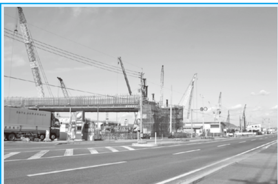
〔古閑跨線橋〕 平成21年9月開通予定
