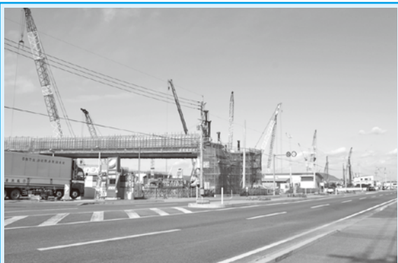
〔古閑跨線橋〕 平成21年9月開通予定
