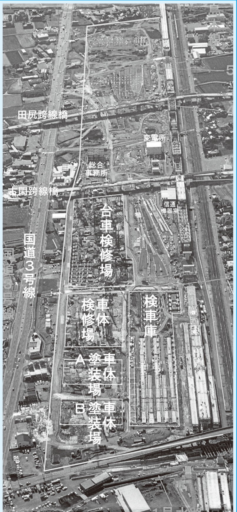
空から見た工事現場。支援機構より提供（12月26日撮影）
