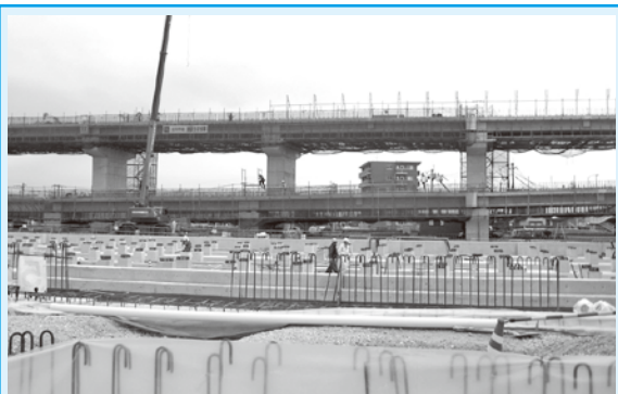
高架橋も着々完成にむけ建設中！ 手前の検車庫は鉄骨の組み立てが始まるのでしょうか？
