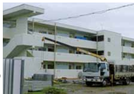
廻江住宅の建設着々と 9月3日撮影
