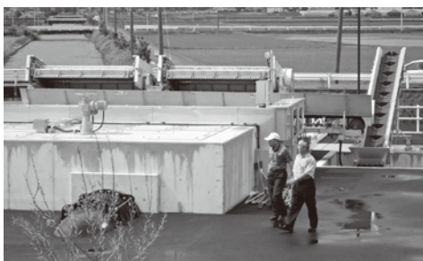
浜戸川堤防より見た機場
