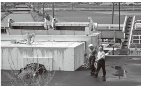
浜戸川堤防より見た機場
