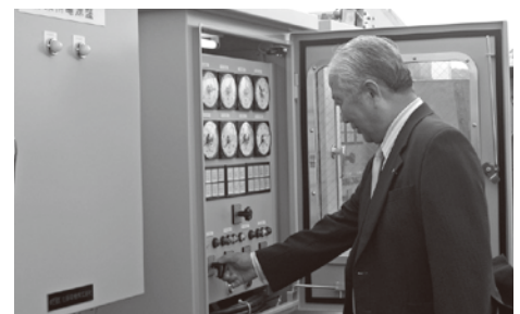
村崎区長により排水ポンプ運転
