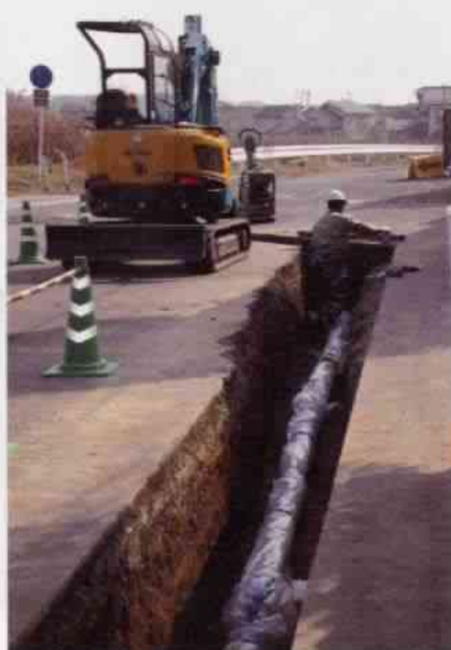
◀水道管の布設工事
