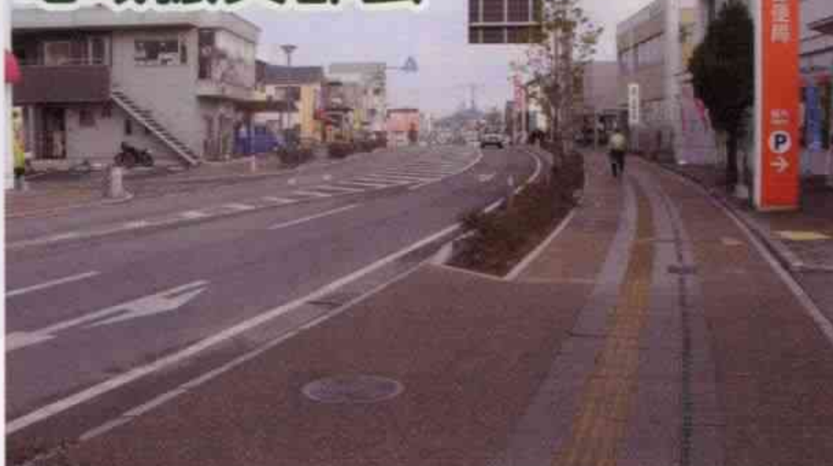
▲整備が進む土地区画整理事業
