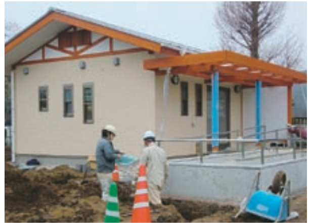
やまびこクラブの施設（山本小学校敷地内）
