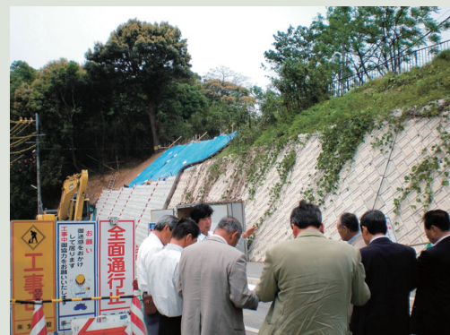
▲松原～停車場線 改良工事現場
