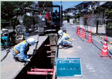
▲下水道工事の現場
