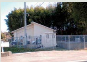
▲汚水中継ポンプ場
