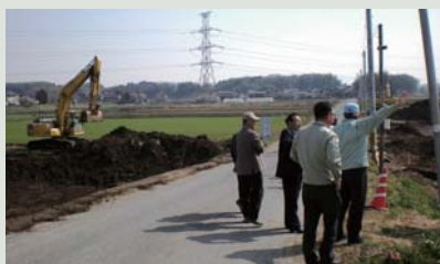
▲合志川流域の災害復旧工事現地
