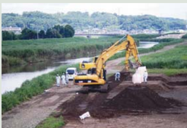
▲掘削工事現場
