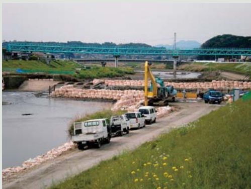
▲復旧中の工事現場
