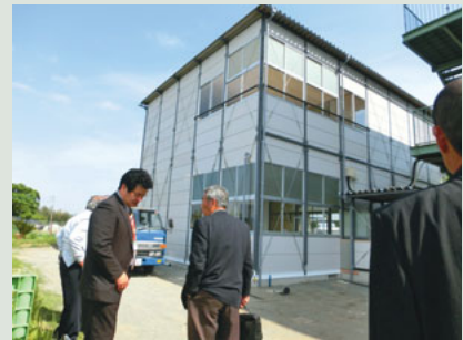
▲植木小に完成した新教室
