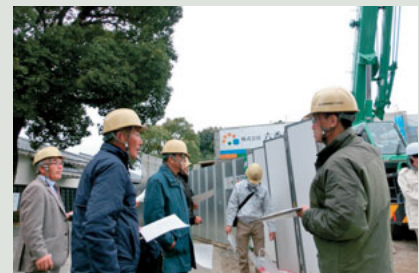
▲建設中の資料館を視察
