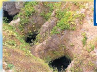
鼻ぐり井手は、現在の菊陽町・馬場楠堰井手に残る清正独創の工法である。井手（用水路）を壁で仕切る構造とし、壁の底部中央に穴を開け、底の水の流れを速くし、阿蘇特有の火山灰土（ヨナ）が底に溜まるのを防いでいる。深く開削した用水路は、人力で水路のヨナをさらうことが難いため、このような仕掛けを考案したと考えられる。今も現役の用水として市内の水田を潤している。
