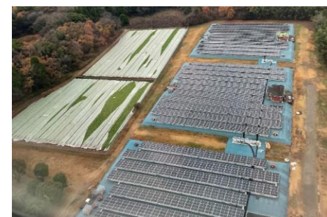
高遊原配水池に設置した太陽光発電
