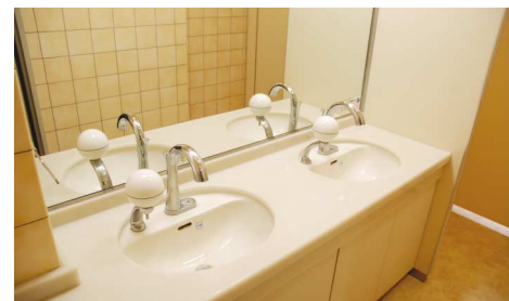
トイレの洗面所は、水の出し過ぎを防ぐために自動水栓に移行。衛生面でも効果的な設備だ
