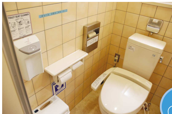
擬音装置が取り付けられたトイレ。今後、すべてのトイレに取り付けを予定。また、昨年にトイレを改修した際、タンクの水容量の少ない節水型のものへ変更されている
