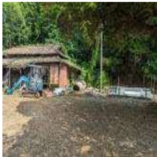
嶽麓寺跡 観音堂改修
