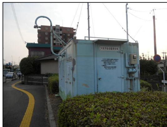
自動車排ガス測定局（神水本町局）
