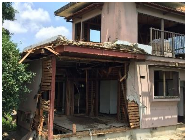
写真 5-2-18 木造・鉄骨造 2 階建て専用住宅の解体状況
