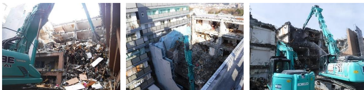
写真 5-2-15 1階部分が座屈したマンションの解体状況
