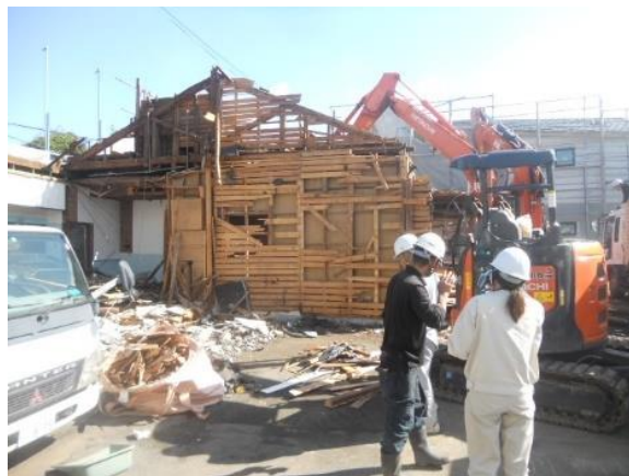
写真 5-2-4 解体現場立入風景
