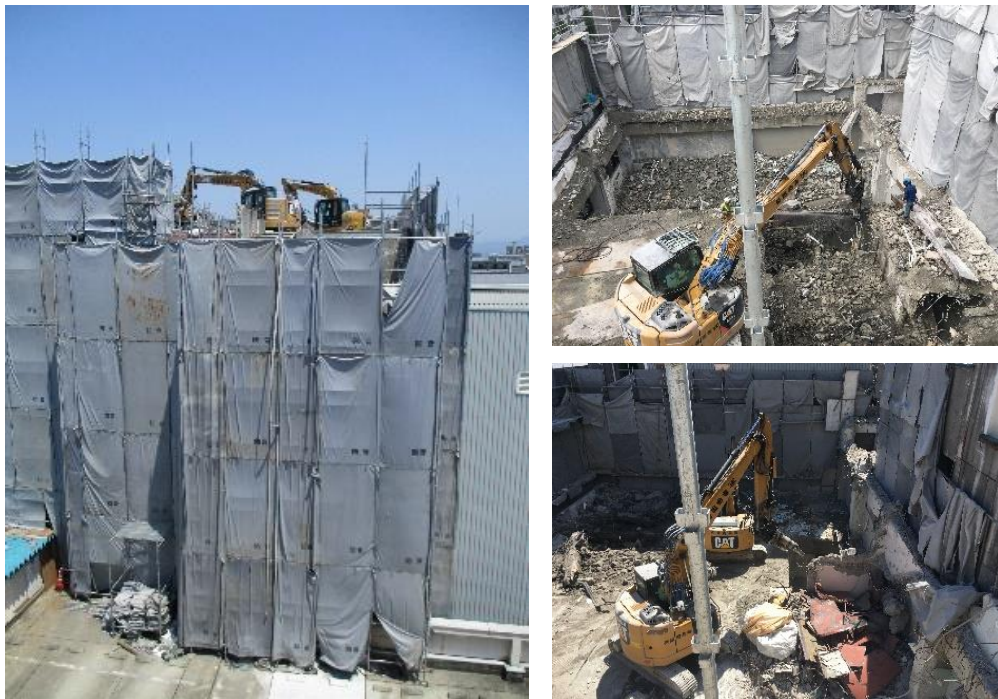
写真 5-2-13 階上解体状況
