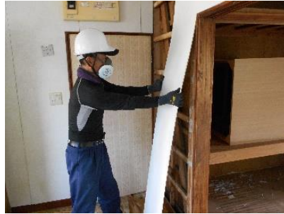
写真 5-2-6 内部解体の状況
