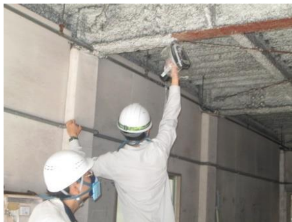
写真 5-2-2 アスベストアナライザーによる調査
