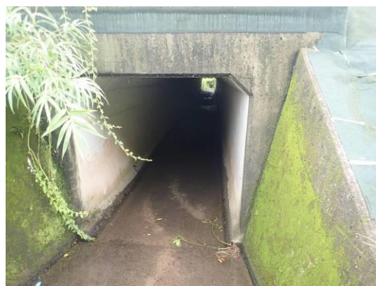
地区環境（水路に設置された暗渠）
