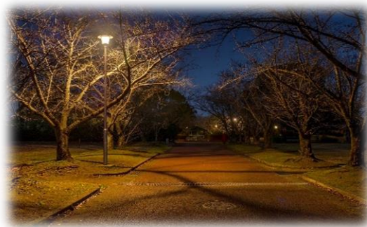
公園照明灯のLED化
