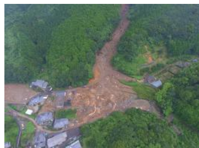
被害状況（津奈木町福浜地区） 資料：熊本県「県内の被害概要（令和2年7月豪雨）」
