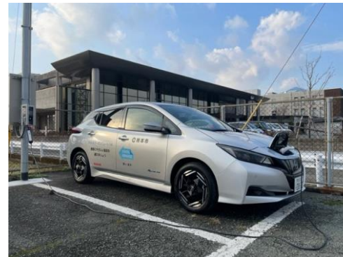
【電気自動車・普通充電設備】
