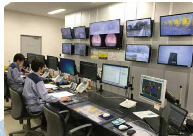
중앙 제어실 플랜트 설비 전체의 운전 상황을 집중 감시 및 제어하고 있습니다. 각 설비는 컴퓨터 시스템에 의해 자동 운전되고 있습니다.
