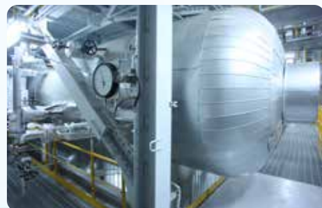
보일러 쓰레기 연소에 의해 발생하는 열을 보일러에서 흡수하여 연소 가스의 온도를 낮추는 것과 동시에 고온·고압 증기를 발생시킵니다.
