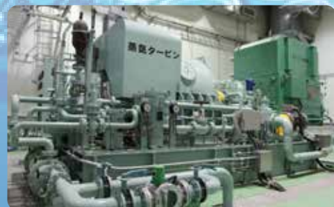
증기 터빈 발전기 보일러에서 발생한 증기를 이용하여 증기 터빈을 돌려 최대 5,980kW의 전기를 발전합니다. 남은 전력은 전력회사로 보내져 일반 가정에서도 사용됩니다.
