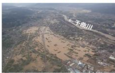
【令和元年東日本台風】
