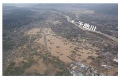
【令和元年東日本台風】
