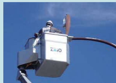
電気設備工事やとび・土工事で地域を支える
