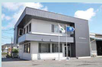
道路や河川工事など、人々の暮らしを支える
