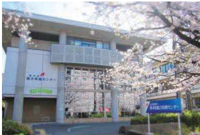
現在の熊本県総合保健センター外観
