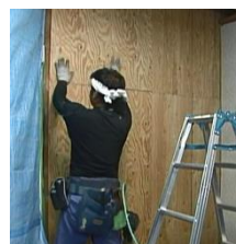
構造用合板の設置
