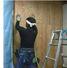
構造用合板の設置
