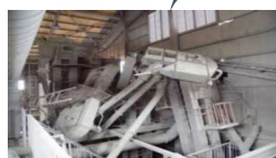
被災した 杉上第二ライスセンター
