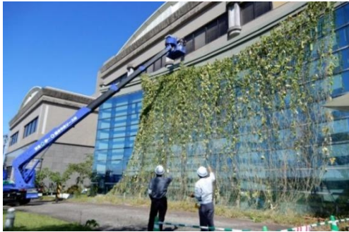
外壁タイルの点検状況
