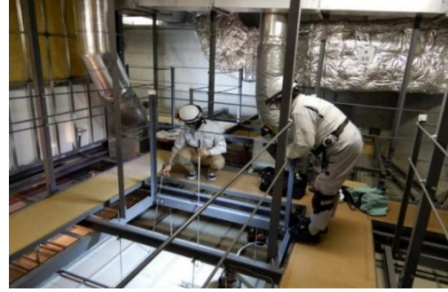
施設内部の点検状況
