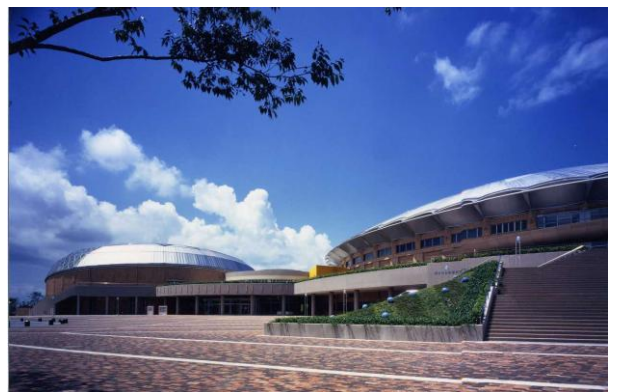
総合屋内プール
