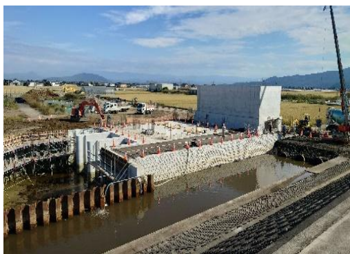
更新工事中の第1海路口排水機場（南区海路口町）
