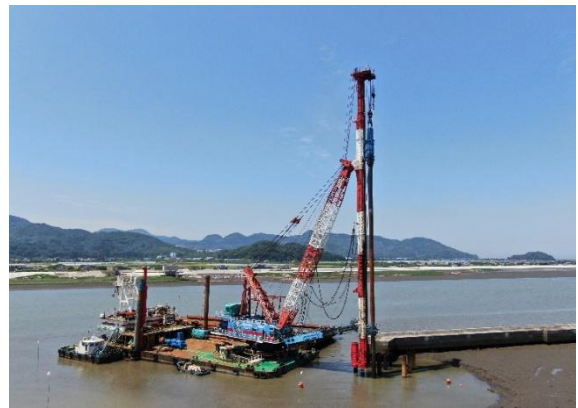
天明漁港物揚場整備状況
