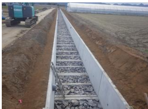
整備後の排水路
