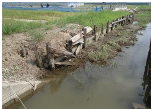
未整備の排水路（土水路）
