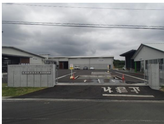
東部堆肥センター
