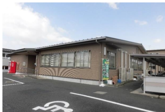
東区土木センター
