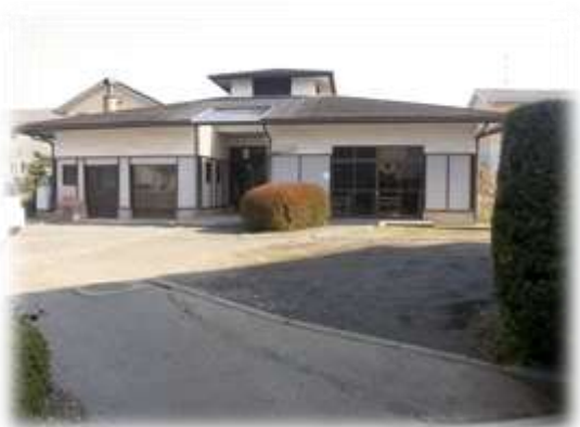
水前寺高齢者生きがい作業所
