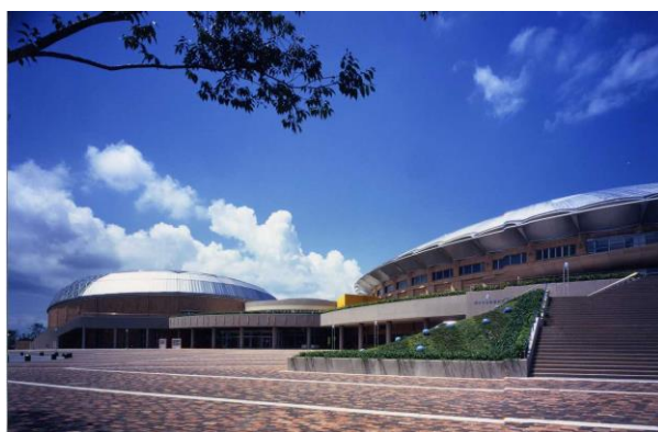
総合屋内プール
