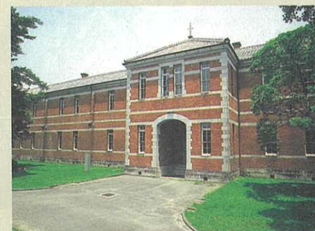
旧第五高等学校本館(熊本市黒髪)
