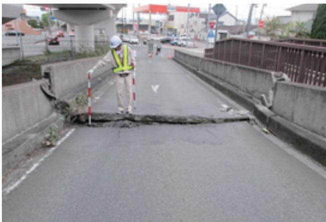
平田高架橋 取付道路の沈下
