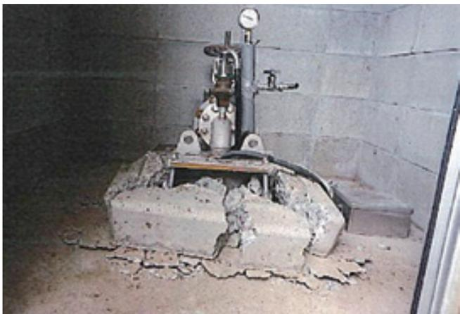
工業用水道施設 井戸ポンプの破損状況
