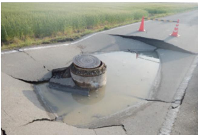
下水道（管路）の被災状況
