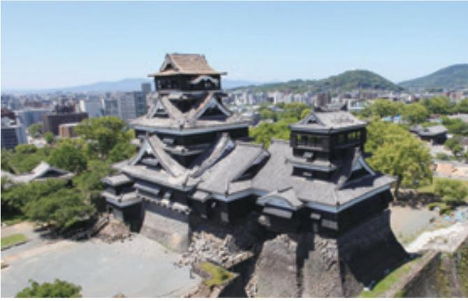
大小天守の破損と石垣の崩落
