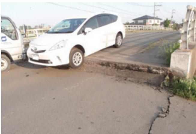
上沼山津橋 橋台背面の沈下
