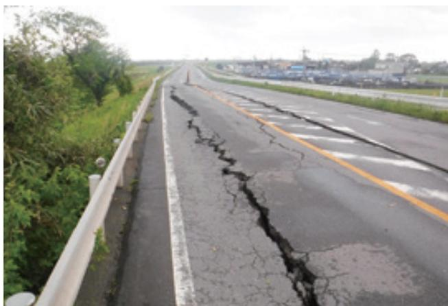
市道緑川堤防線 堤防道路の亀裂陥没
