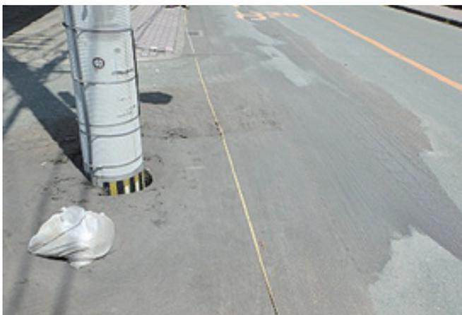
市道世安町八幡 5 丁目第 1 号線（近見付近）液状化による電柱の沈下
