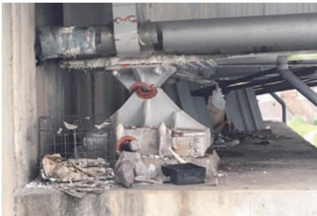
白川橋 鋼製支承の損傷
