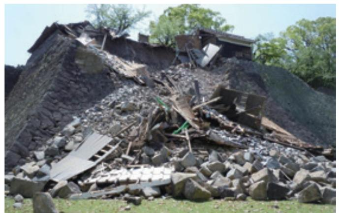
北十八間櫓の石垣崩落と櫓の倒壊
