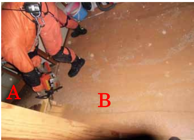
フローリング切断状況（Cポイントは写真より外）
