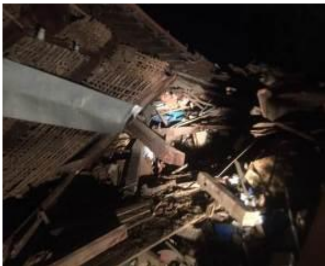
倒壊した建物南東側 進入ポイント
