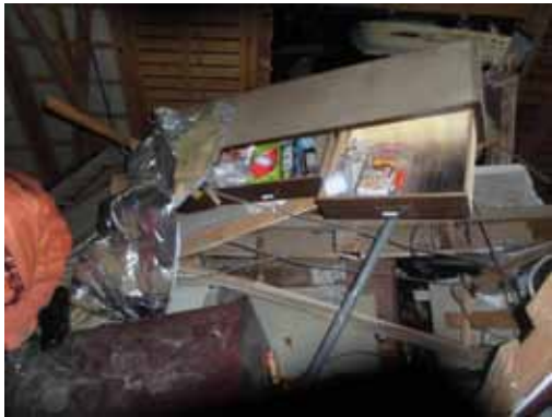
2 階部分の状況
