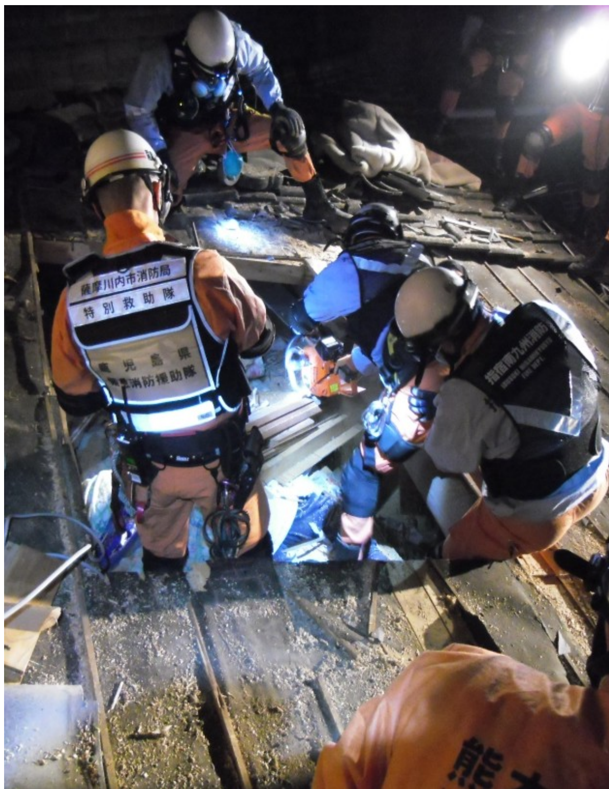
屋根を破壊し、進入を試みる
