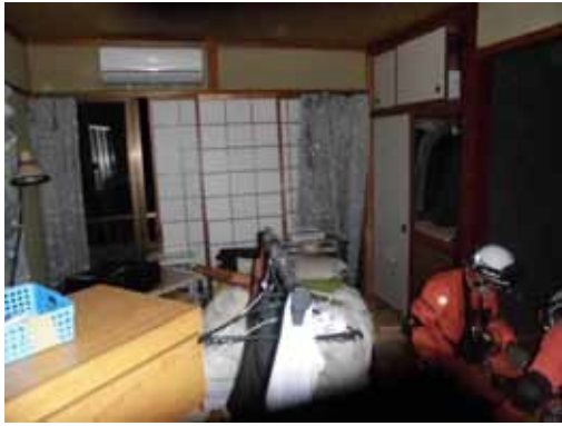
2 階部分の状況
