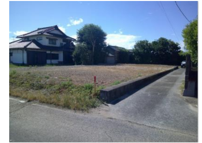
2024年8月 空き家は解体
