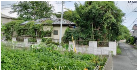
管理不全な状態の空き家
